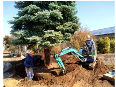
▲ 既存樹の移植作業風景（2024年2月・3月撮影）
