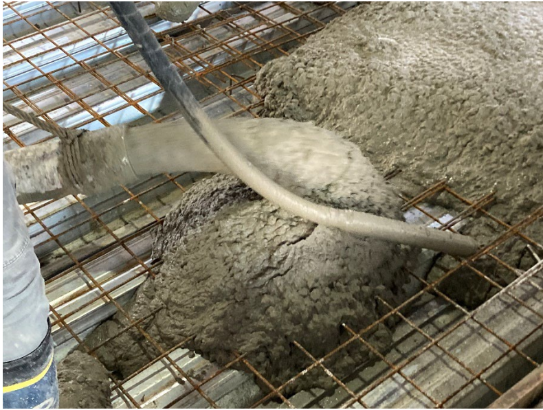
▲コンクリート打設状況
