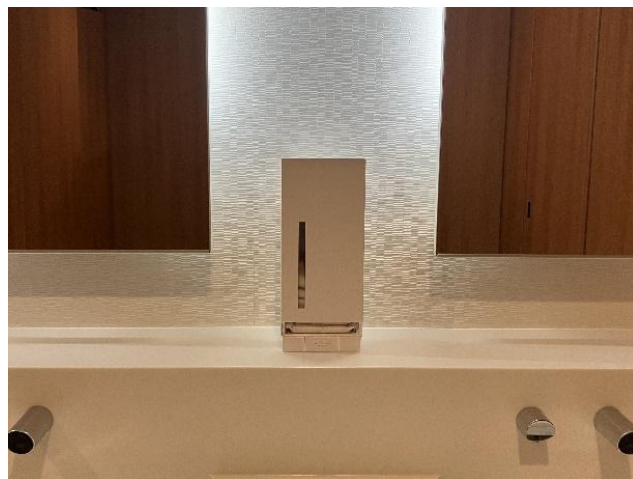
トイレ内設置の様子
