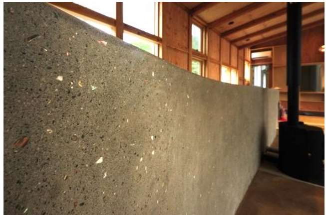
釜石のホタテ、アワビの貝殻を入れたコンクリート壁
