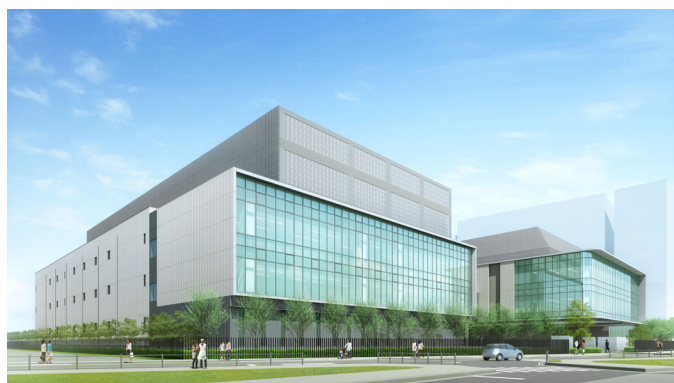
西東京データセンター 2号棟
