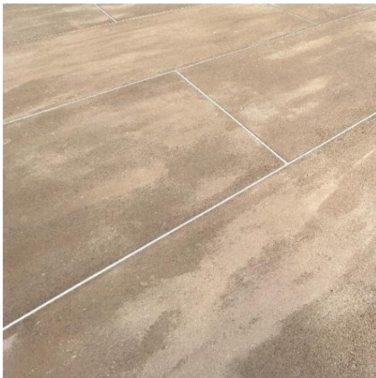
モルタル拡大写真
