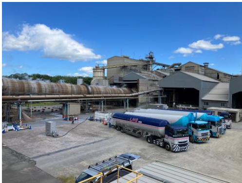
LNG ロリー車を用いた天然ガス供給
