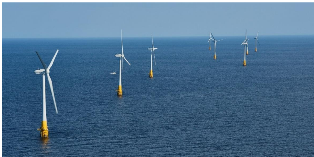
風車 8 基の全景
