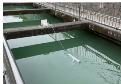
東西分木工での設置状況
