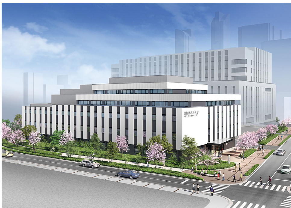
武蔵小杉キャンパスに建設中の教育施設棟(※本パース現時点でのイメージであり完成時とは異なる場合があります。)
