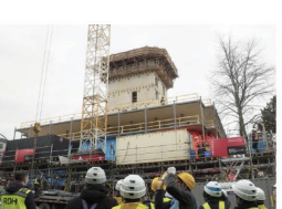
中大規模木造建設現場の視察
