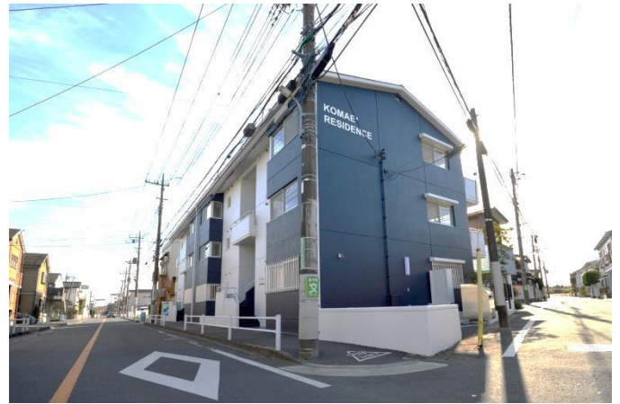
<狛江レジデンス外観:リノベーション後>
