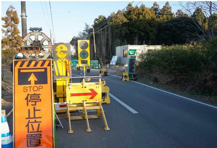
AI ガードマンロボット信号機は、AI 信号機と現場監視機能を持たせたガードマンゲートユニットで構成され、従来の信号機の、誘導効率と安全性を向上させた商品です。株式会社レント、株式会社ティオック、中村建設株式会社、3 社で道路規制現場のニーズをくみ取り、共同で商品化しました。
