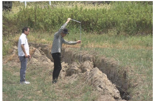
熊本地震でむき出しになった断層のずれ
