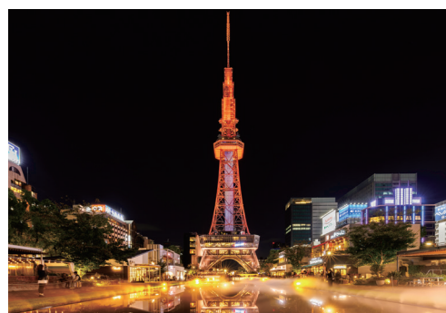
中部電力 MIRAI TOWER(実施:名古屋市)
