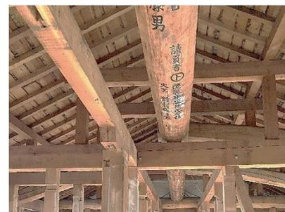
事前の現地調査の結果、構造に大きな損傷や腐朽がなかったため、既存の躯体を活かしたリノベーション工事を実施。
