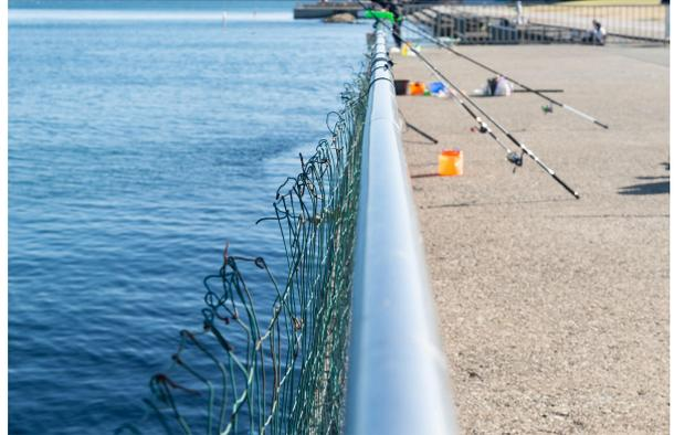
改修前の防護柵。緊急措置として施した金網製ネットとプラスチック製結束バンドが経年劣化等で壊れている箇所も見られる。
