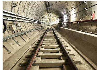
地下トンネル
