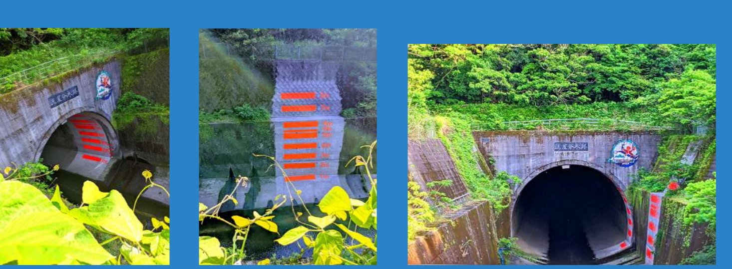
肝属川鹿屋分水路 荻原1号橋付近 (令和4年度)
