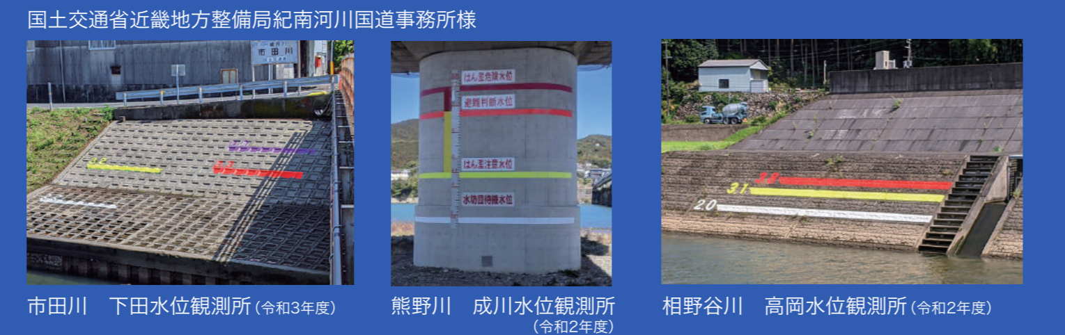
市田川 下田水位観測所 (令和3年度) 熊野川 成川水位観測所 (令和2年度) 相野谷川 高岡水位観測所 (令和2年度)
