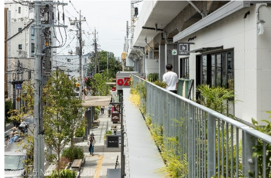
2階デッキ通路
