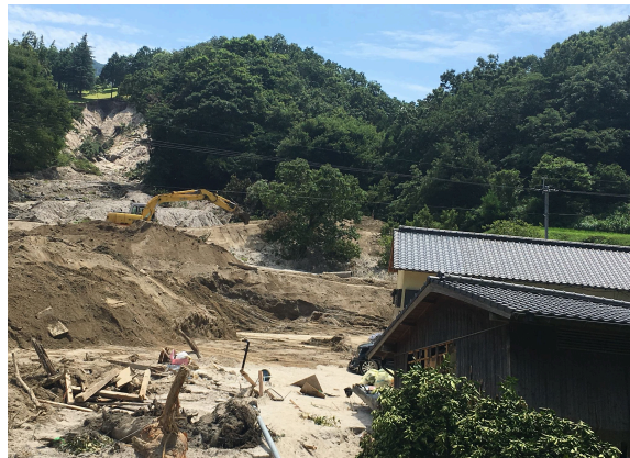
土砂崩れ現場の復旧作業（福岡県）
