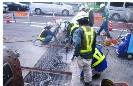
伸縮装置の取替工事では、コンクリートブレーカーなどを使用するため騒音が大き。振動の発生や粉じんの飛散、大型の重機を使用するため排気ガスによる環境負荷も大きい
