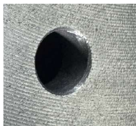
ネジ穴の未加工
