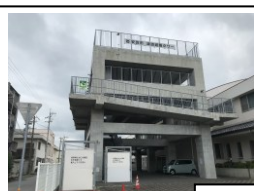
津波避難タワー
