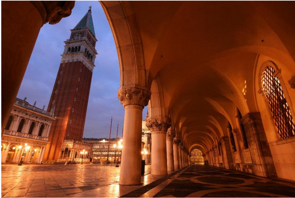
サンマルコ広場にある鐘楼（Campanile di San Marco）と回廊
