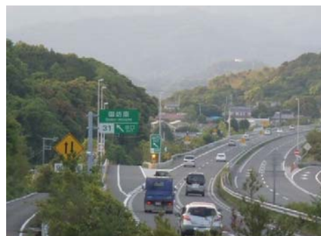
写真: 阪和自動車道 御坊IC～御坊南IC
