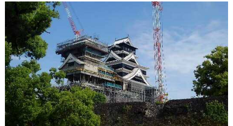
↑復旧工事中(令和元年5月撮影)
