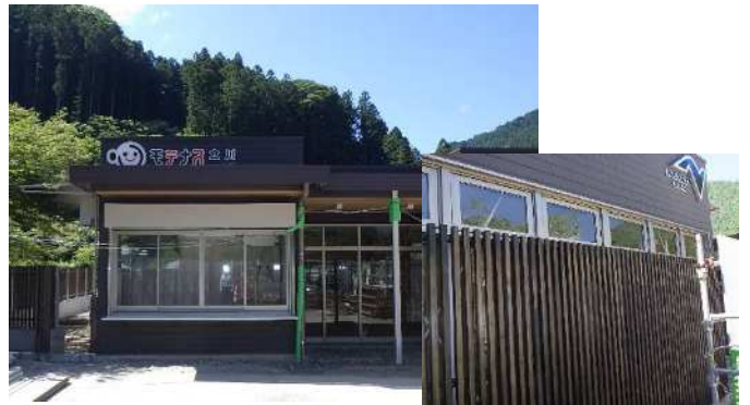
(周辺景観と調和した木目調の外観)
