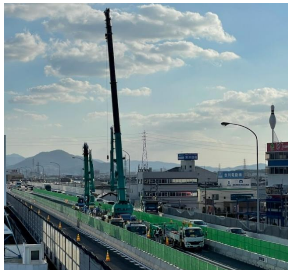
撤去状況(遠景)
