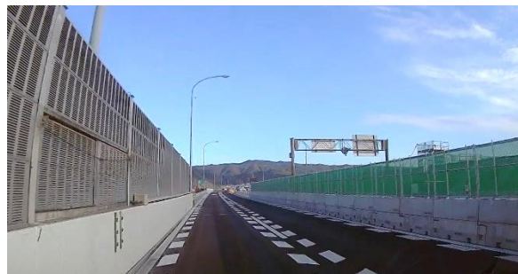
幅員減少規制の状況(通行車内)
