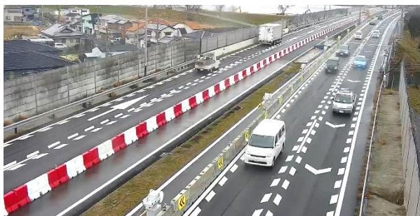
幅員減少規制の状況(遠景)
