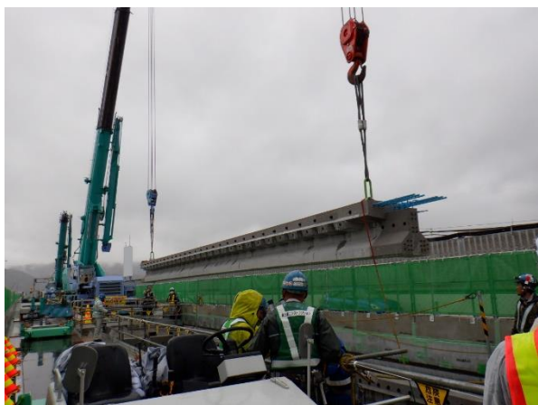
コンクリート桁の架設状況
