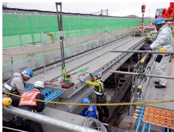
コンクリート桁の架設状況
