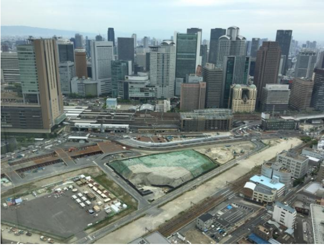
梅田スカイビルからのうめきた2期工事の様子
