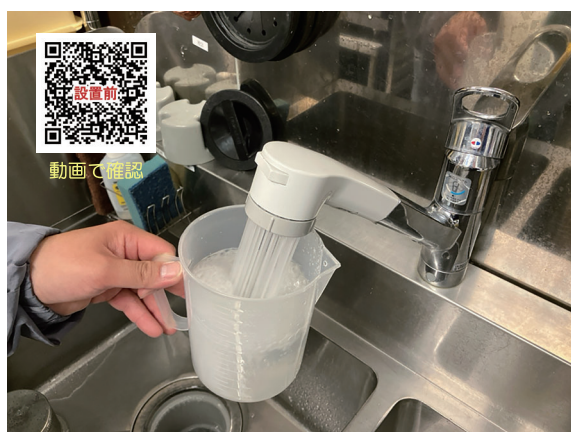
既設の混合シャワー水栓 13.2L/分
