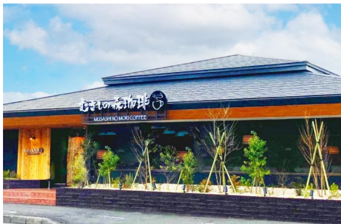
「むさしの森珈琲 静岡千代田店」店舗外観
