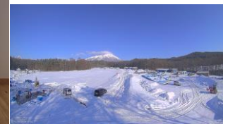
建設中の様子(2025年1月撮影)
