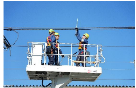
電車線の検査作業
