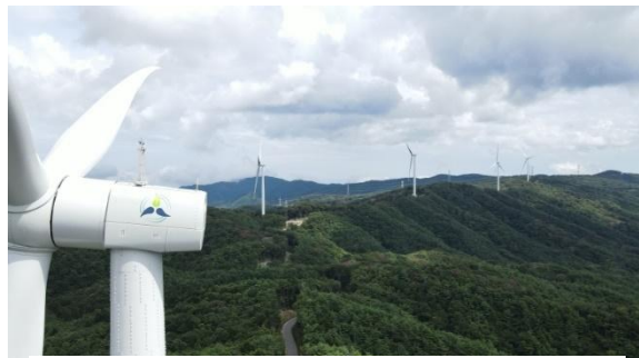
かわうち鬼太郎山風力発電所（福島県）
