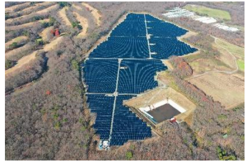
池田太陽光発電所（栃木県）
