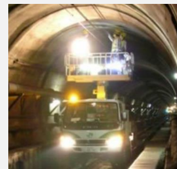
土木構造物の検査・修繕
