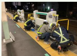
ホームドア工事
