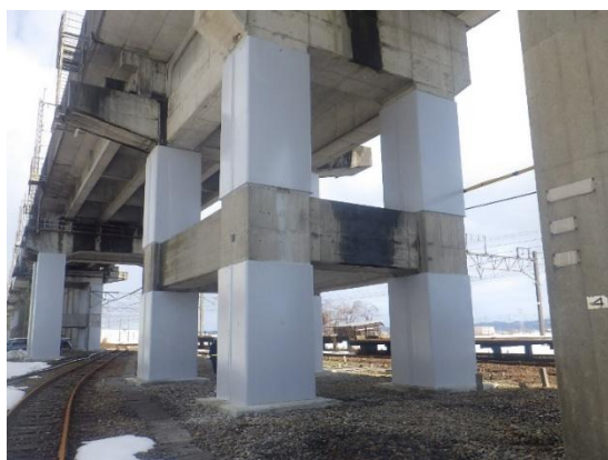
高架橋柱（鋼板巻立て）
