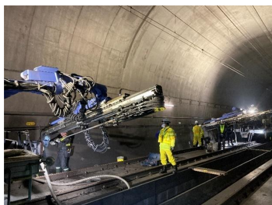
山岳トンネル（ロックボルト打設）
