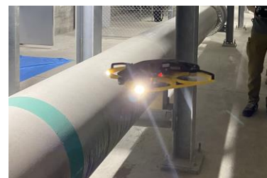
ドローンを活用した設備点検
