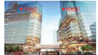
<象徴となる南街区グランドシャフトのイメージ（西新宿一丁目交差点西側より望む）>
