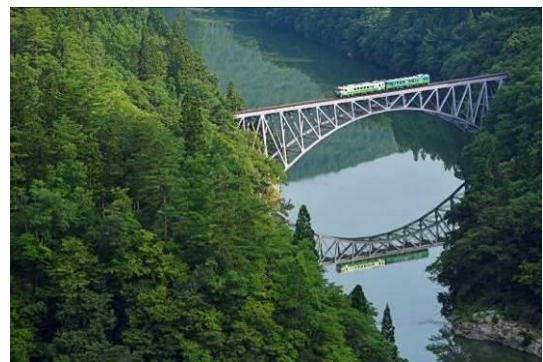
真夏の第一只見川橋梁
