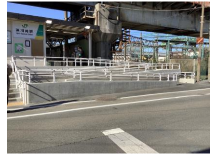
スロープ (浜川崎駅)
