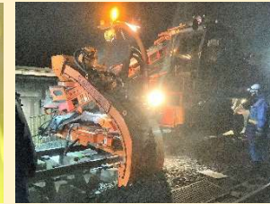
道床交換工事
