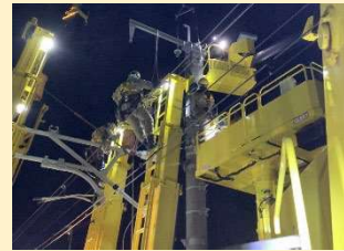
電柱耐震工事
