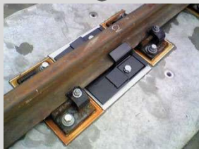
レール転倒防止装置の設置
