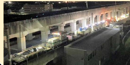
保守基地から施工場所に向かう大型機械
