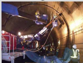
トンネルへのロックボルト施工
