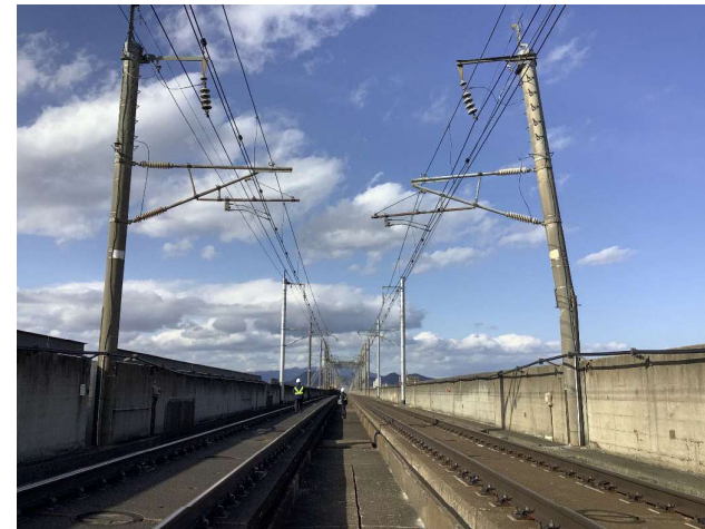
福島県沖地震での電柱傾斜
