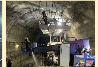
トンネル補強工事
