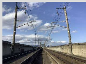
電柱傾斜防止
