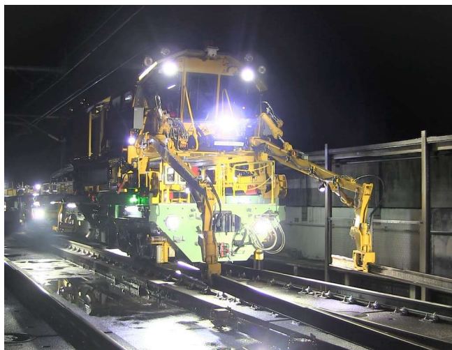
レール更新車によるレール更新工事
