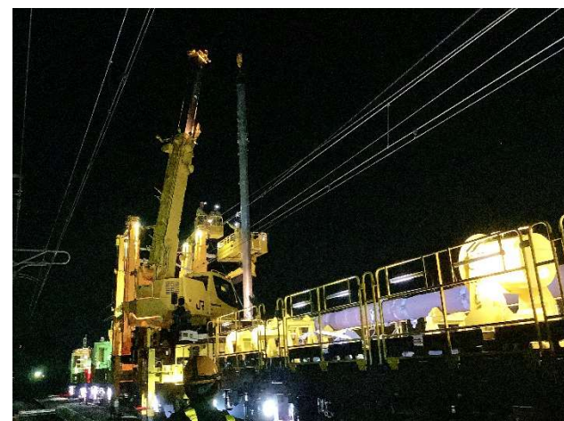
鋼管製の電柱への取り替え
