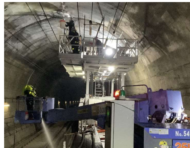
作業用車によるトンネル補強工事
