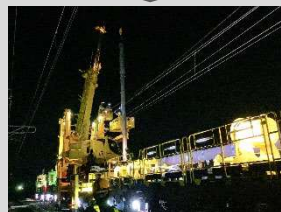
鋼管製の電柱への取り替え
