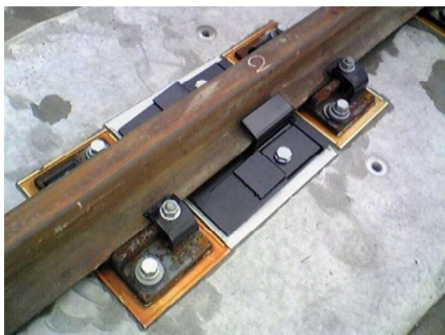
レール転倒防止装置の設置
