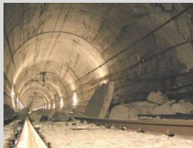
トンネル剥落防止
