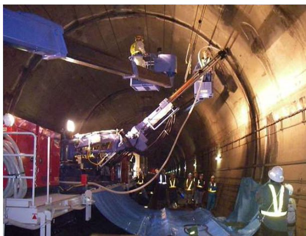
トンネルへのロックボルト施工
