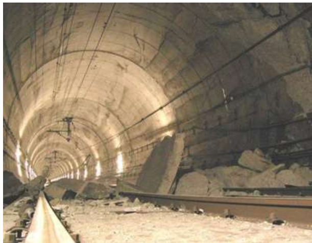
新潟県中越地震でのトンネル剥落
