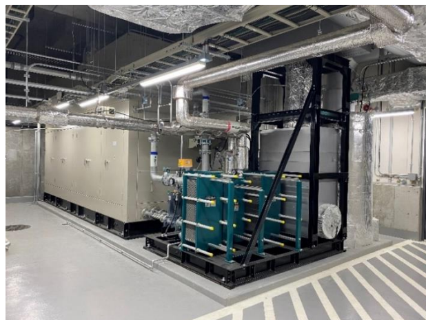
CGS 現地外観
