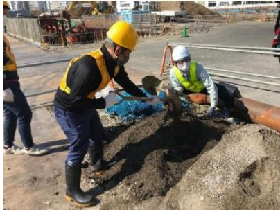
【開発予定地の掘削残土の再利用】
