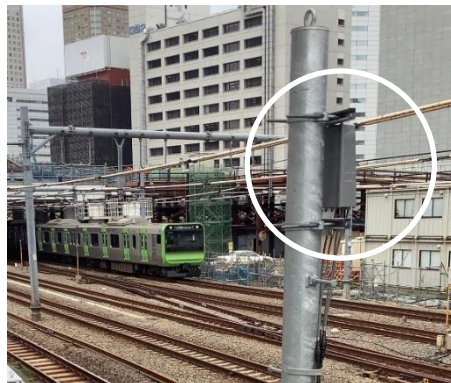
高輪ゲートウェイ駅～品川駅間 5G アンテナ（囲み丸部分）
