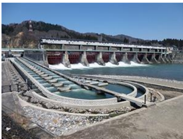
【魚道の整備（新潟県十日町市）】
