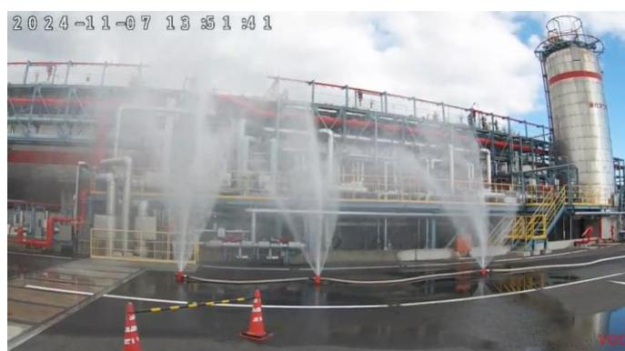
貯蔵タンクから漏れた有毒の液化アンモニアを放水している様子(訓練)
