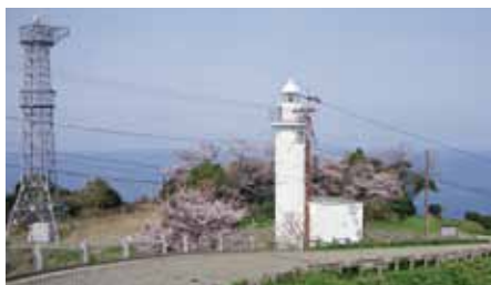
越前岬灯台(平成25年) 平成20年(2008)、耐震対策のため20m北東に移設、建替え。福井県の主要な航路標識で、若狭湾の東角にあり、京都府『経ヶ岬灯台』と対峙している。地上16m、灯高は海面上131m。
