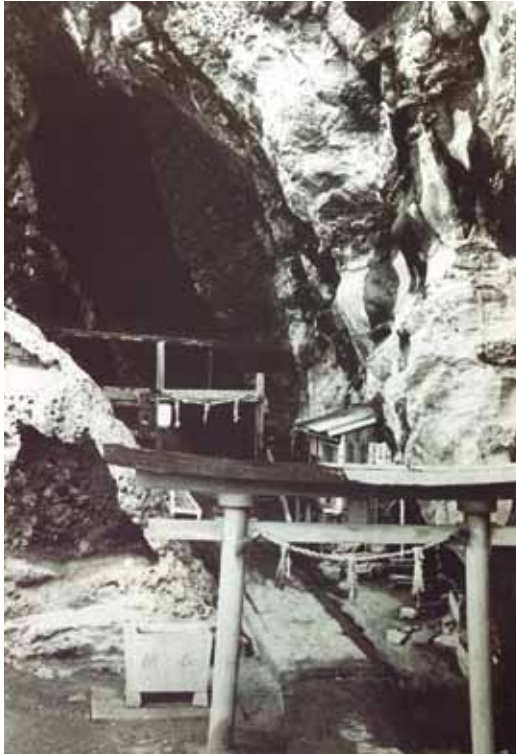
玉川観音(昭和23年頃)海食により自然にできた洞窟は33㎡余りの大きな空洞で、海中から揚がったといわれる観音様を祀っていた。国道305号線が通るまでは、玉川からは細い道で、他の地区からは船で渡り参拝していた。
