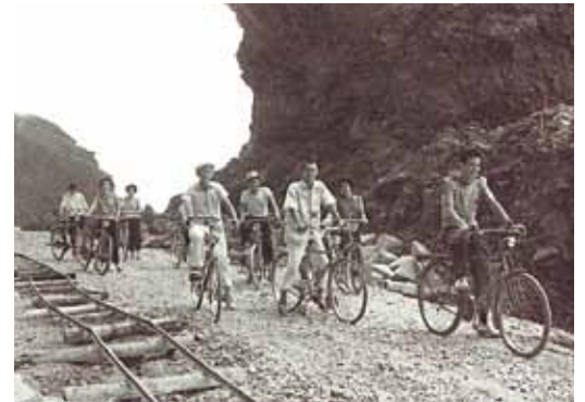
海岸道路工事の様子(昭和29年頃)
