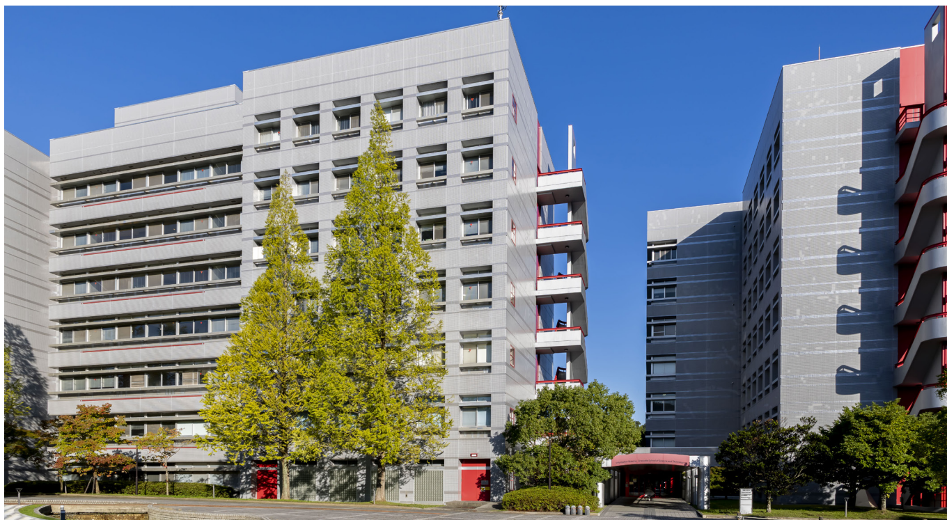
念入りな事前サイトサーベイにより学内全域で安定した Wi-Fi 無線接続を実現
