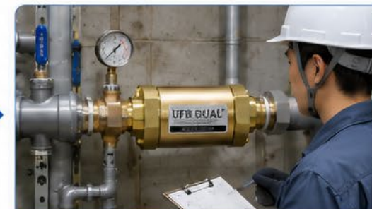
4. 通水・漏水確認
